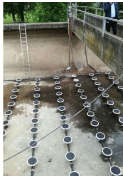
Livenza Tagliamento Acque S.p.A. Ristrutturazione depuratore Concordia Sagittaria Importo lavori € 216.037
