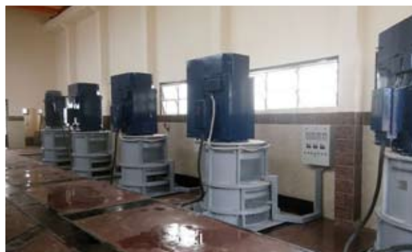
Ministry of Water Resources and Irrigation - Egypt Rifacimento parziale impianti di pompaggio El-Thawra 2,4 Importo lavori € 1.039.767
