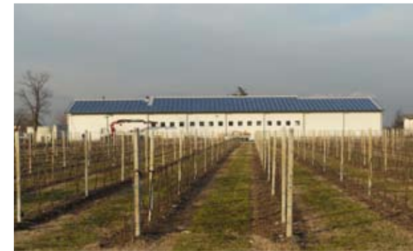
Consorzio di Bonifica Piave Impianto fotovoltaico Bolda Importo lavori € 315.000
