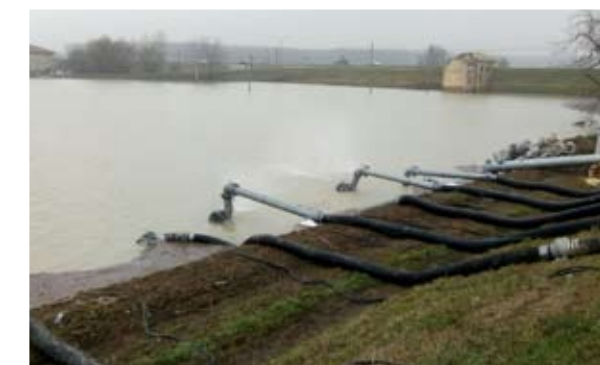
Eventi sismici del maggio 2012 Consorzio di Bonifica dell'Emilia Centrale Ripristino funzionalità dell'impianto idrovoro Mondine
