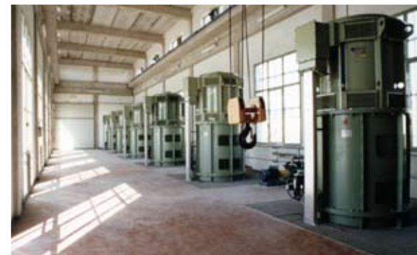
Consorzio di Bonifica Padana Polesana Impianto idrovoro Bresparola Importo lavori € 1.310.820
