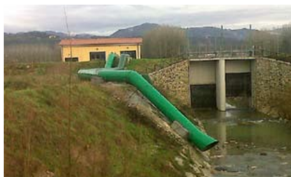
Provincia di Lucca Regimazione impianto Rio Freddanella Importo lavori € 549.471
