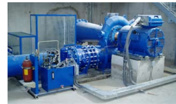
Consorzio di Bonifica Medio Astico Bacchiglione Centrale idroelettrica Astichelli Importo lavori € 288.790
