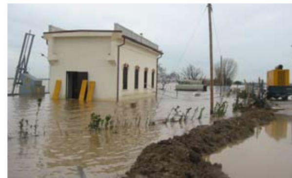
Comune di Pasiano di Pordenone Intervento di emergenza per la piena del fiume Meduna, 2010
