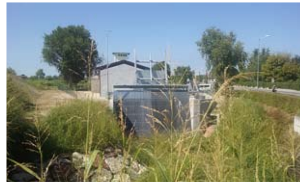
Consorzio di Bonifica Piave Potenziamento impianto Fossa dei Negadi Importo lavori € 783.584
