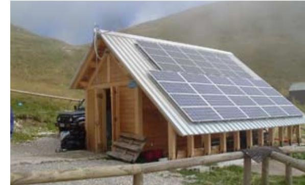
CAI - Club Alpino Italiano Rifugio Dal Piaz Importo lavori € 60.088
