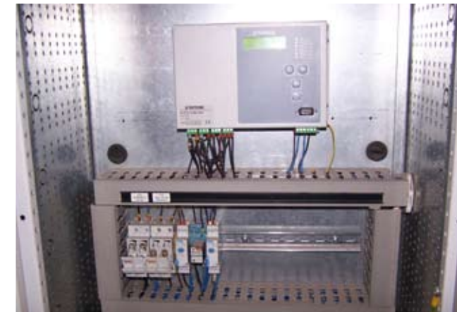
ETRA S.p.A. Adeguamento tecnologico MT/BT presso il polo rifiuti di Bassano Importo lavori € 87.700
