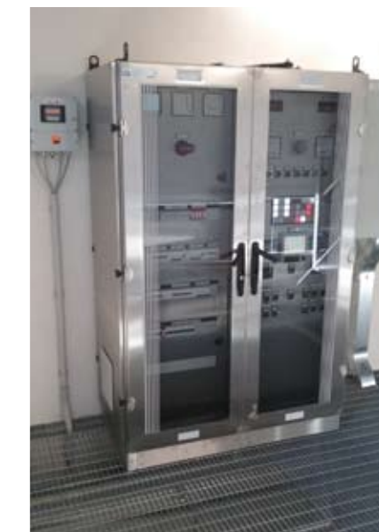
Acque Vicentine S.p.A. Ampliamento serbatoio acquedotto Tonin Importo lavori € 142.206
