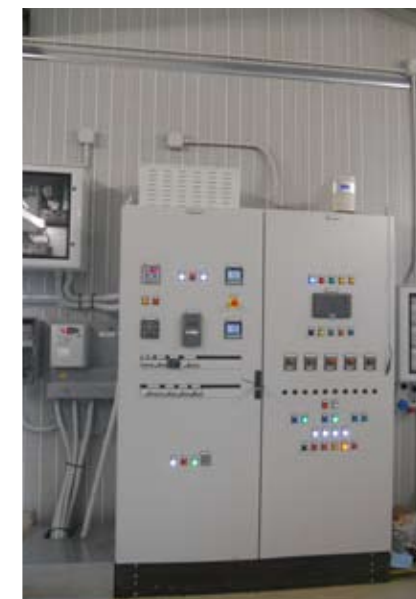
Consorzio di Bonifica Piave Centralina San Vito Importo lavori € 360.000
