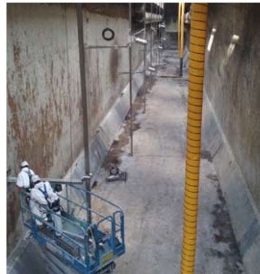
Acque del Chiampo S.p.A. Sistema di miscelazione del denitrificatore dell'impianto di depurazione di Arzignano (VI) Importo lavori € 140.534
