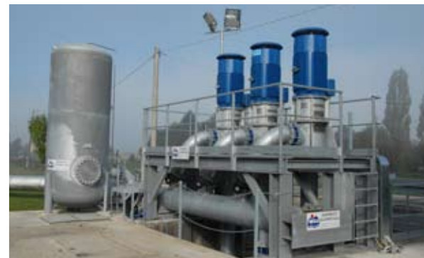
Consorzio della Bonifica Burana Impianto pluvirriguo Concordia Sud - Emergenza terremoto in Emilia, Misa realizza un impianto in 20 giorni Importo lavori € 165.316
