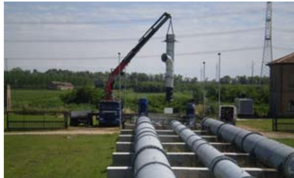
Consorzio di Bonifica Delta Po Adige Impianto idrovoro Conca Importo lavori € 443.715
