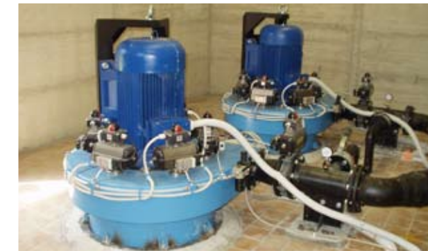
Comune di Vinadio Minicentrale idroelettrica torrente Neraissa Importo lavori € 158.565
