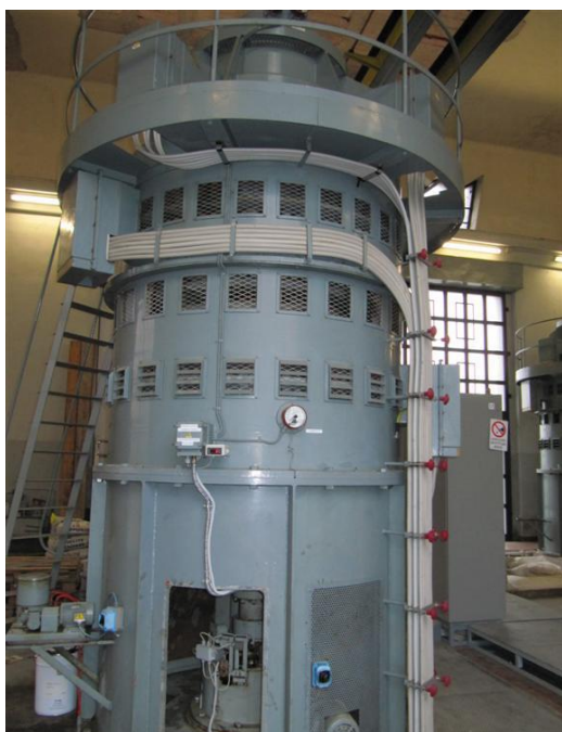
A lato: Motore Pellizzari GAS 5000/22 n=267 g/1 CV=1100 V=550
