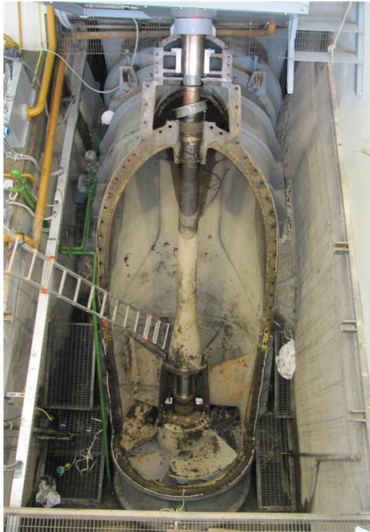
Riparazione gruppo n. 1 di pompaggio Pellizzari tipo FIER 10.000 nell'impianto Crevenzosa.
