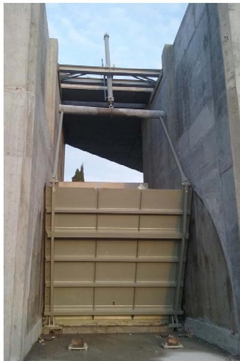
N. 1 Paratoia sghiaiatrice 2,77 x 3,30 m, tenuta 3 lati, in acciaio al carbonio S355JR, comando oleodinamico
