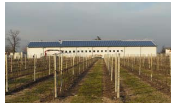
Consorzio di Bonifica Piave Bolda photovoltaic system Amount of work € 315.000
