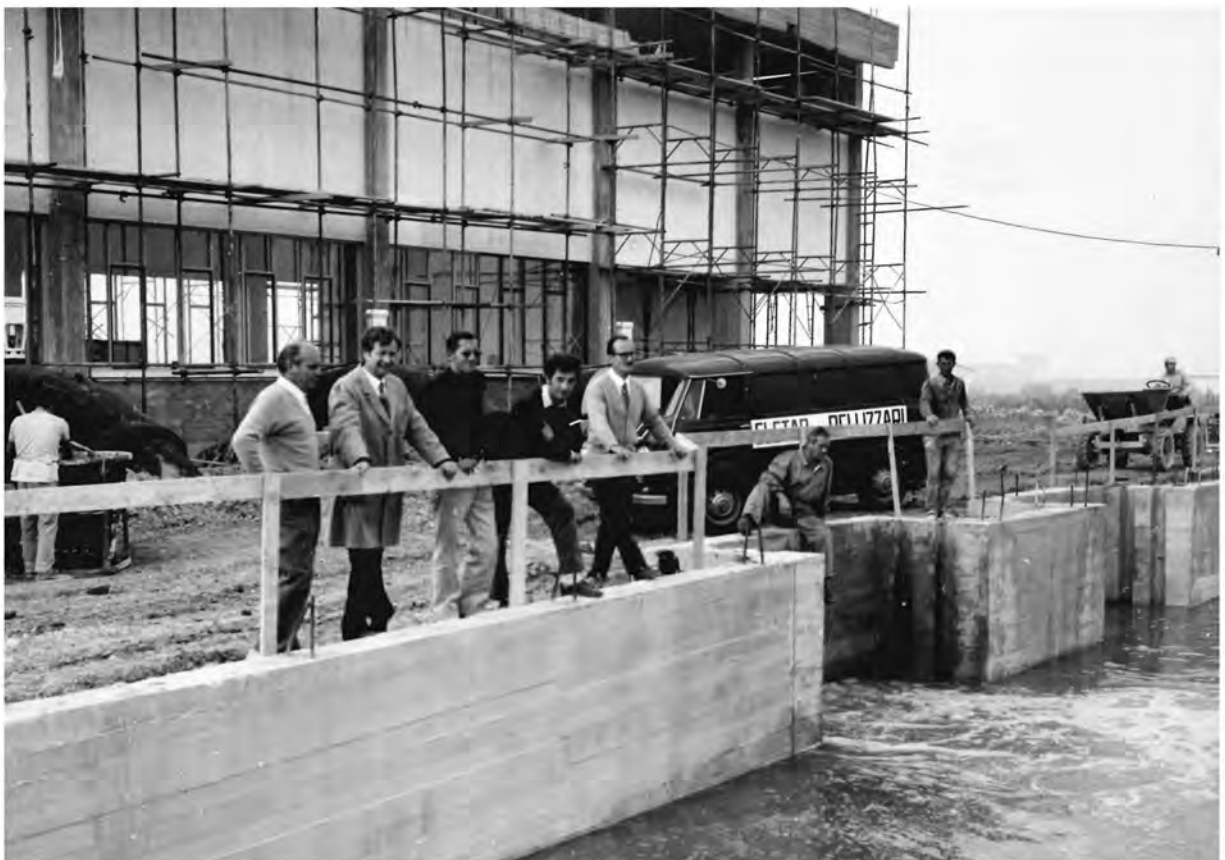
Primo avviamento impianto idrovoro Valle Tagli - 24 settembre 1971
