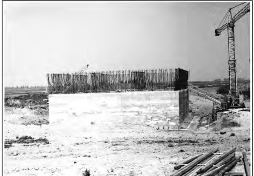
Idrovora Valle Tagli: cassone autoaffondante gettato e disarmato - maggio 1970
