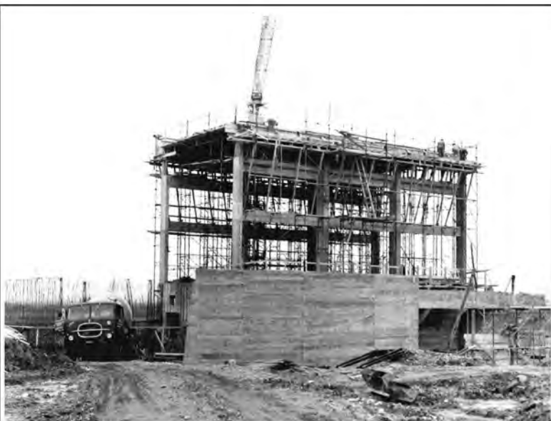
Costruzione idrovora Valle Tagli - marzo 1971
