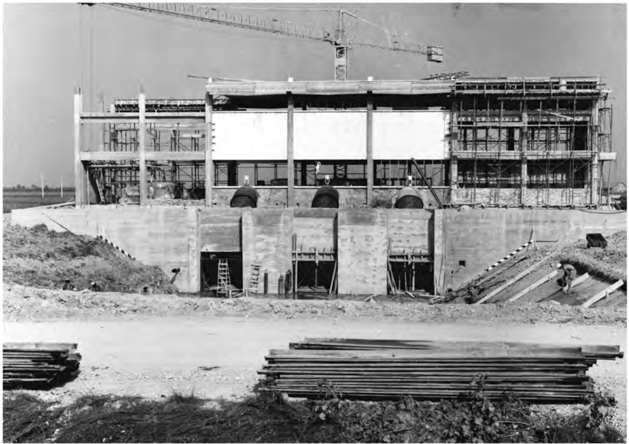
Costruzione idrovora Valle Tagli - agosto 1971
