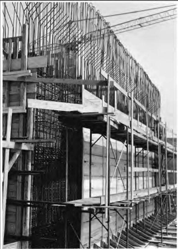
Idrovora Valle Tagli: cassone autoaffondante in fase di armatura - aprile 1970
