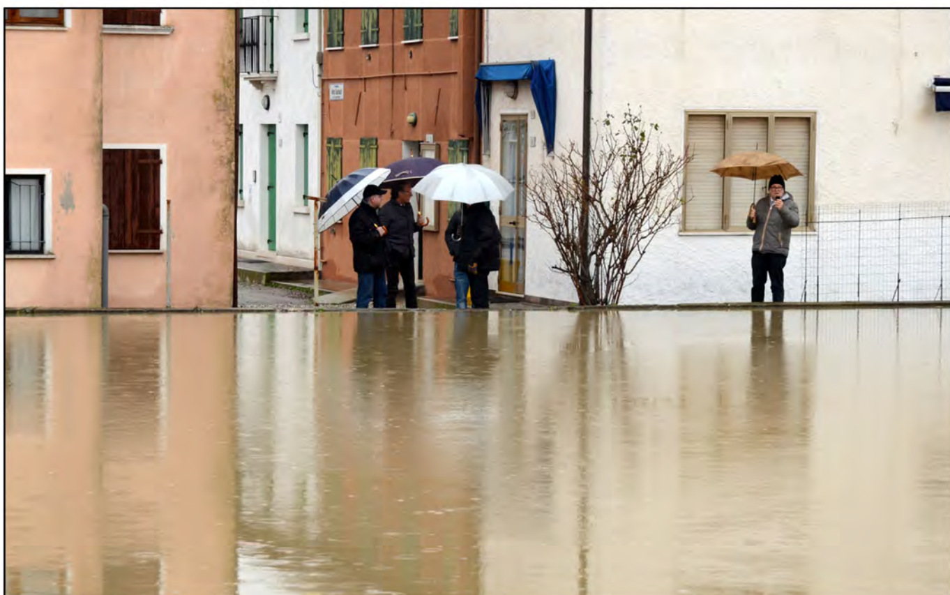
01.02.2014 - Il livello del canale Piavon a Ceggia raggiunge la sommità del muretto di difesa: si effettua lo stacco programmato di alcuni gruppi idrovori per evitare la tracimazione.
