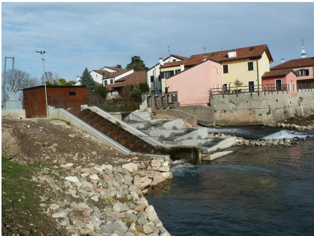
Qui è stata posata una **turbina a coclea** (cosiddetta “vite di Archimede”) sull’esistente salto sul fiume Ceresone, con possibilità di produrre circa 500.000 chilowattora annui. Si è realizzata anche una scala di risalita per i pesci a fianco della turbina.
