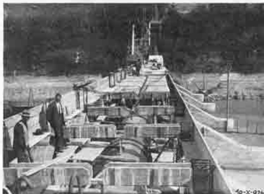
LO SBARRAMENTO È COSTITUITO, PER LA PARTE FISSA, DA UNA SOLIDISSIMA COSTRUZIONE DI « CEMENTO ARMATO » PUSATA SU ROBUSTI PILONI — A GUIDA DI UN ORDINARIO PONTE — CONGIUNGE LA CENTRALE PROPRIAMENTE DETTA ALLA SPONDA SINISTRA DEL FIUME.
