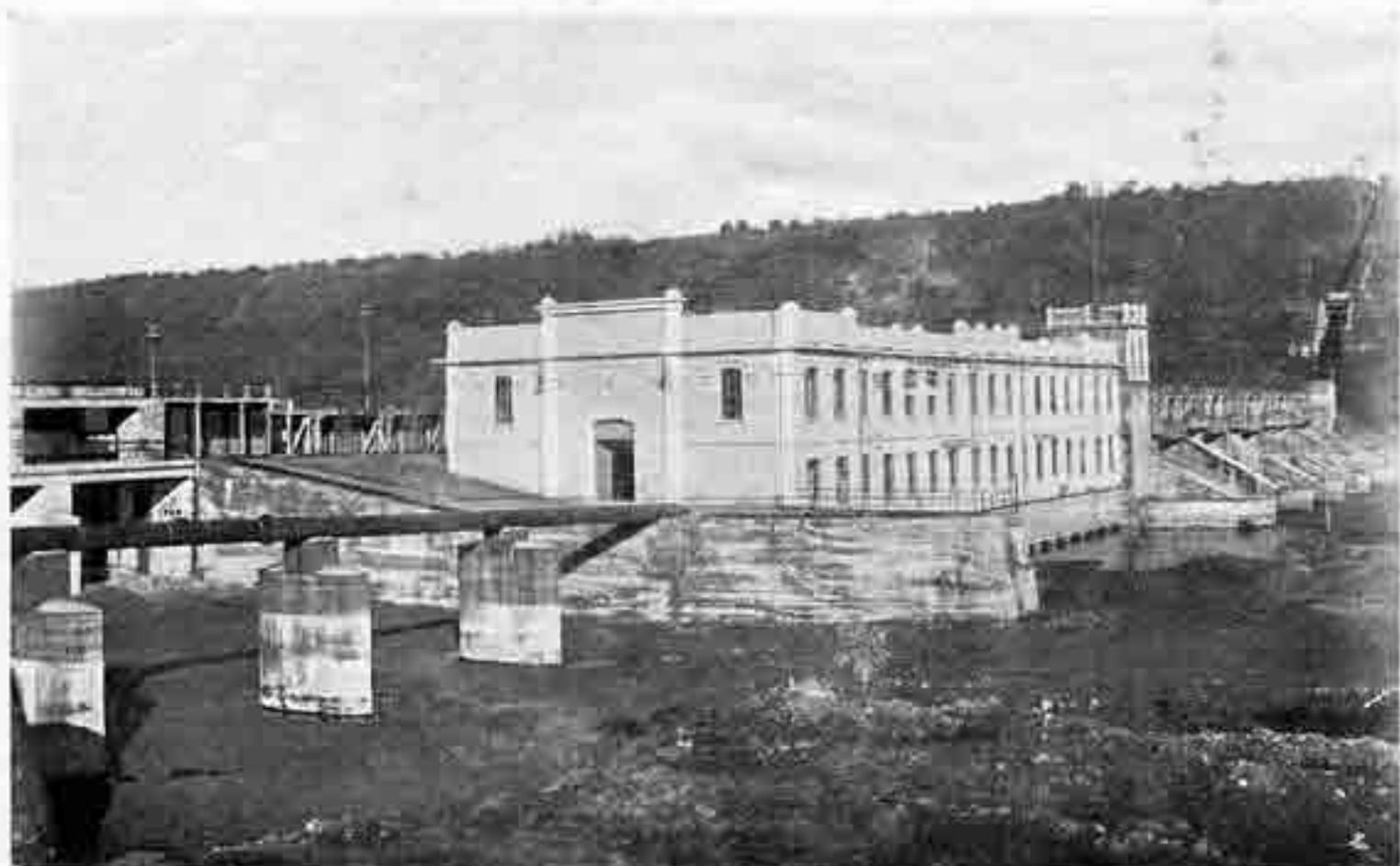
IMPIANTO D'IRRIGAZIONE DI VILLAREGGIA. - L'EDIFICIO DELLA CENTRALE ELETTRICA, È UNA MAESTOSA COSTRUZIONE A TRE PIANI, ESSA PURE FONDATA SU ROBUSTI PILASTRI NELL'ALVEO.
