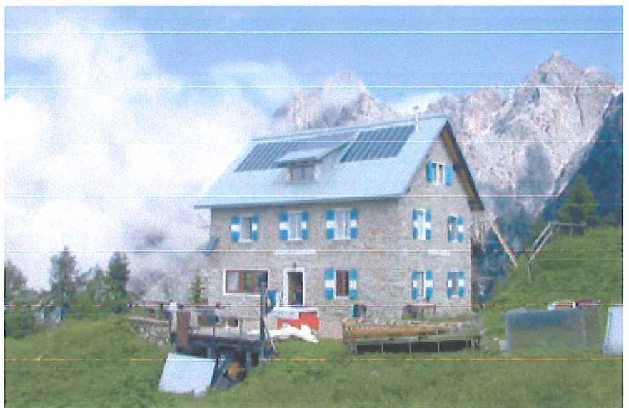
Il rifugio Papa, collocato a 1928 m nel Comune di Valli del Pasubio (VI), dispone oggi di un modulo fotovoltaico UNISOLAR da 64 WP, a tripla giunzione in silicio amorfo, incollato direttamente sulle lastre di copertura in zinco-titanio della RHEIN-ZINK, per un totale a fotovoltaico di 61,54 m<sup>2</sup> su 280 m<sup>2</sup> totali di copertura, realizzata in tre settimane di lavoro dalla LATTONERIA RONCARI con la tecnica della doppia aggraffatura
