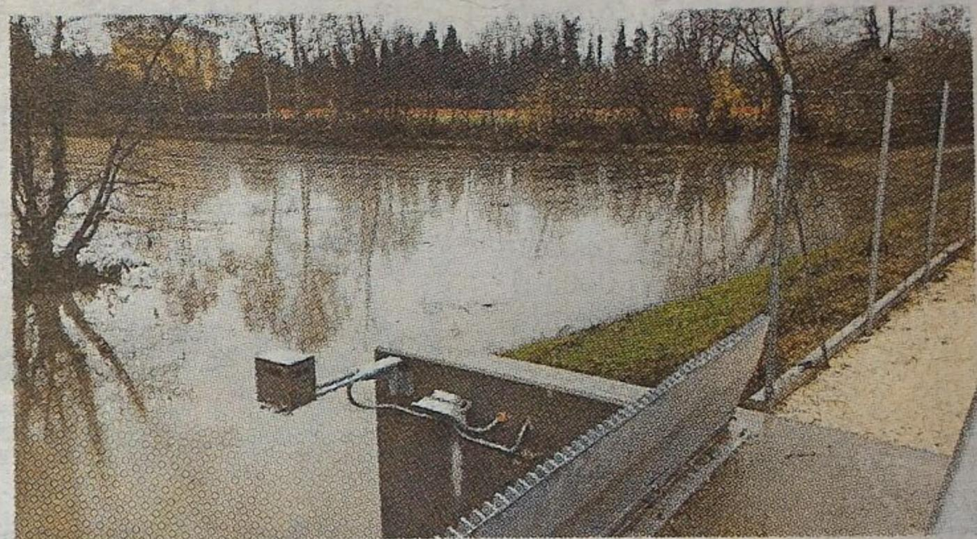
**I nuovi impianti idrovori installati a Vallenoncello e le apparecchiature di controllo del livello dell'acqua durante gli eventi alluvionali**
