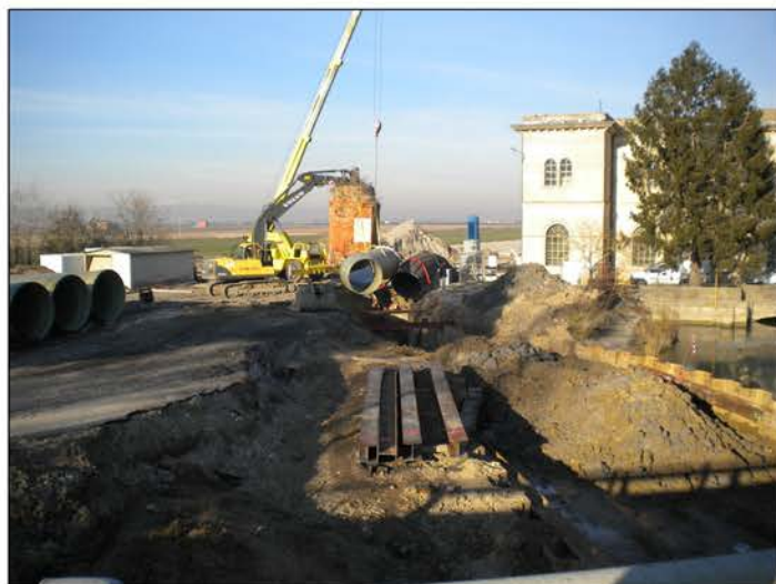
Posa tubazioni scarico
