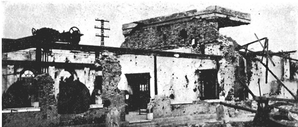
L'IMPIANTO IDROVORO DI CAVAZUCCHERINA DISTRUTTO DALLA GUERRA (LUGLIO 1918)
