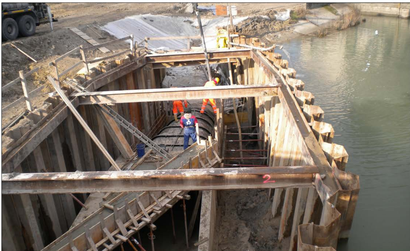
Costruzione della testata di scarico
